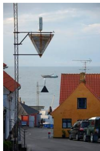
Rysunek 58. Nabieżniki - zestaw dwóch znaków umieszczonych na lądzie, będących w dzień punktami charakterystycznymi, w nocy zaś, nadającymi znaki świetlne o odpowiedniej charakterystyce. Jeden z nich ustawiony wyżej i dalej, na jednej linii z drugim wyznaczają razem oś toru wodnego lub jego krawędź.
