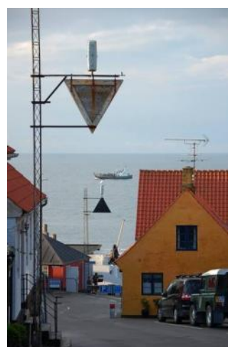
Rysunek 45. Nabieżniki - zestaw dwóch znaków umieszczonych na lądzie, będących w dzień punktami charakterystycznymi, w nocy zaś, nadającymi znaki świetlne o odpowiedniej charakterystyce. Jeden z nich ustawiony wyżej i dalej, na jednej linii z drugim wyznaczają razem oś toru wodnego lub jego krawędź.
